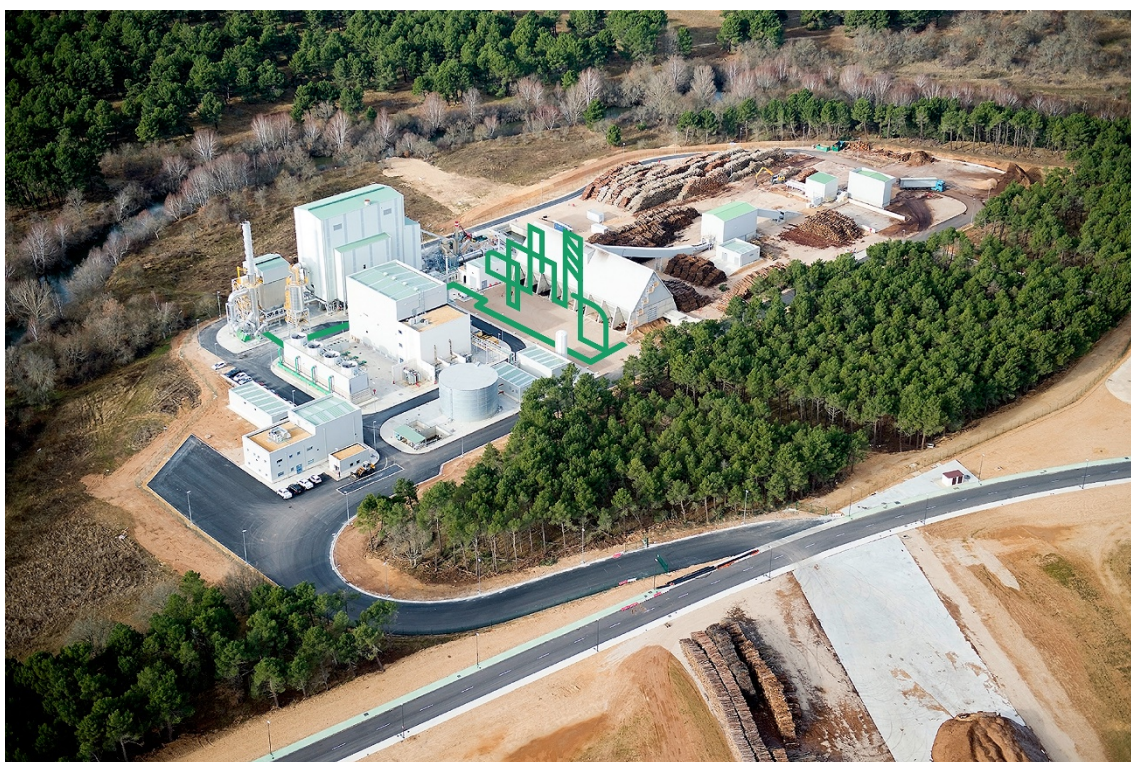
Figura 1. Planta actual de producción de energía eléctrica a partir de biomasa y proyección de la futura planta anexa de captura y depuración de CO 2 (proyecto LIFE CO 2 IntBio)
